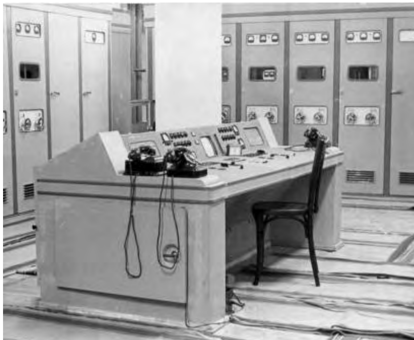
Fig. V.3.1. Pupitrul de comandă al emițătoarelor de imagine și sunet (care parțial, se văd în fundal)
