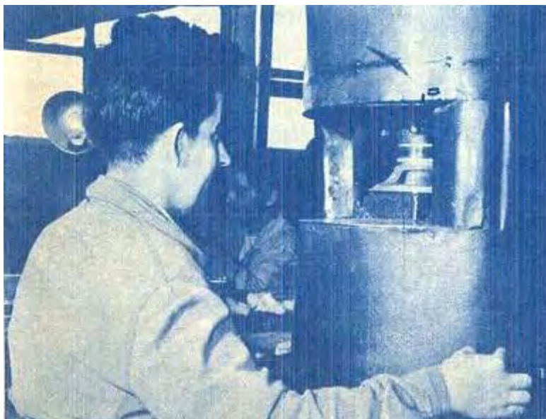
Fig II.6.1.3 Presarea la cald a membranei – tehnologia anilor 1960 (foto Gheorghe Mihai)
