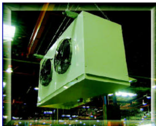
Figura 53. Detalle de los evaporadores AIRCOIL.
